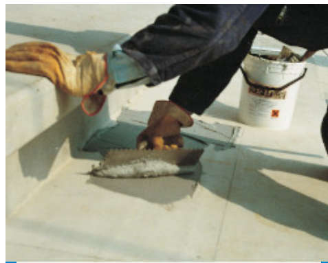
Applicering av Adesilex PG1 med tandspackel för förbindning av prefabricerade trappsteg
