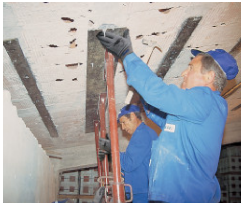
Placering av metallskiva för förstärkning av konstruktion
