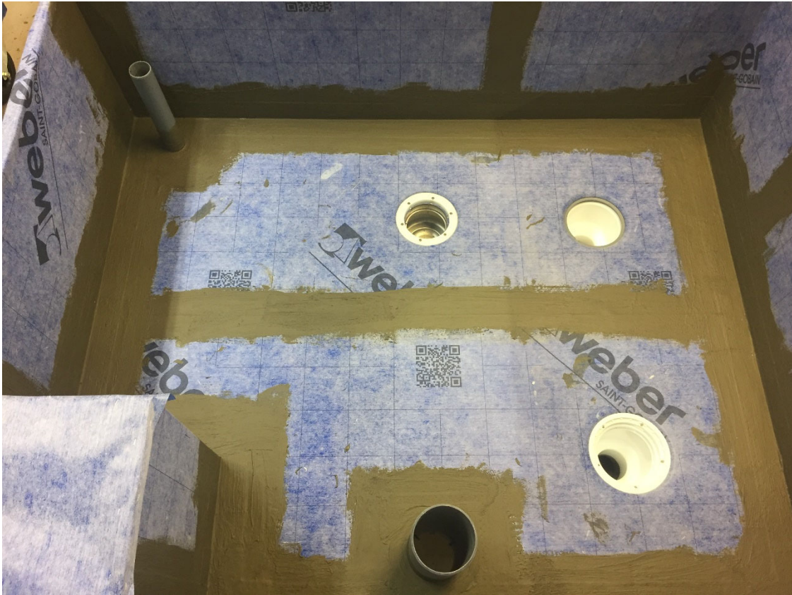
Provlådan färdig för provning
