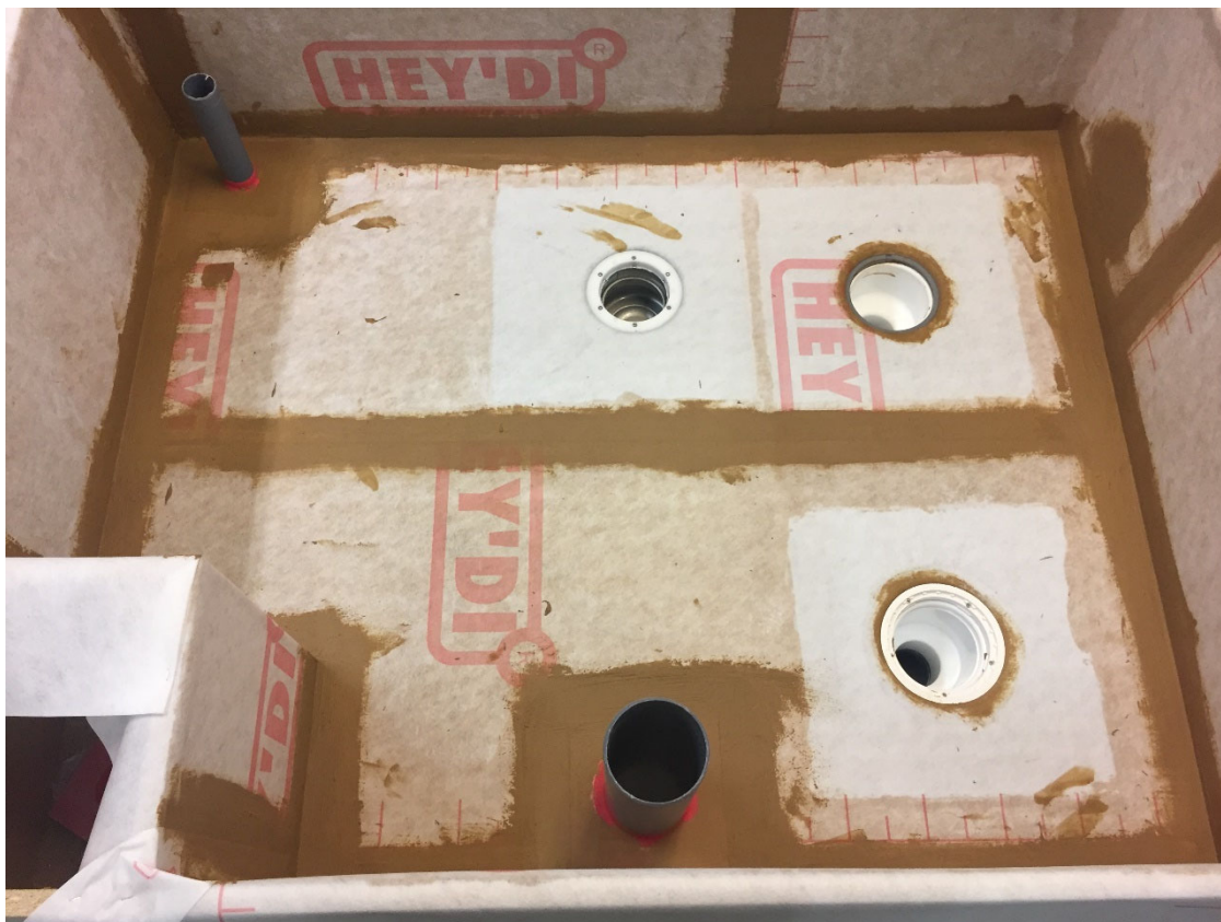
Provlådan färdig för provning
