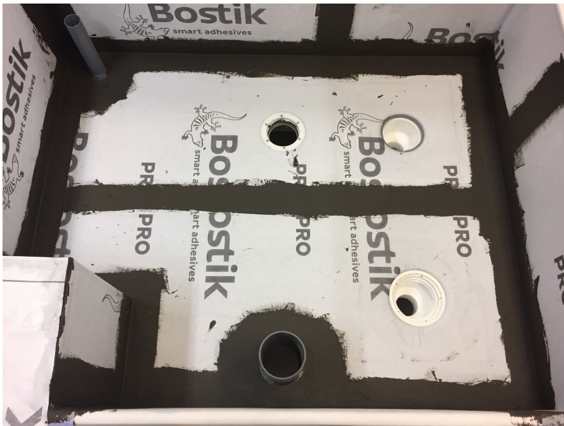
Provlådan färdig för provning
