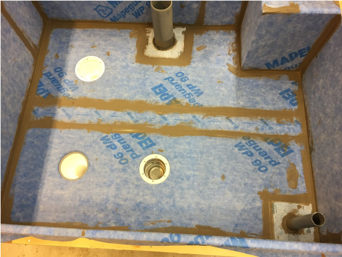
Provlådan färdig för provning
