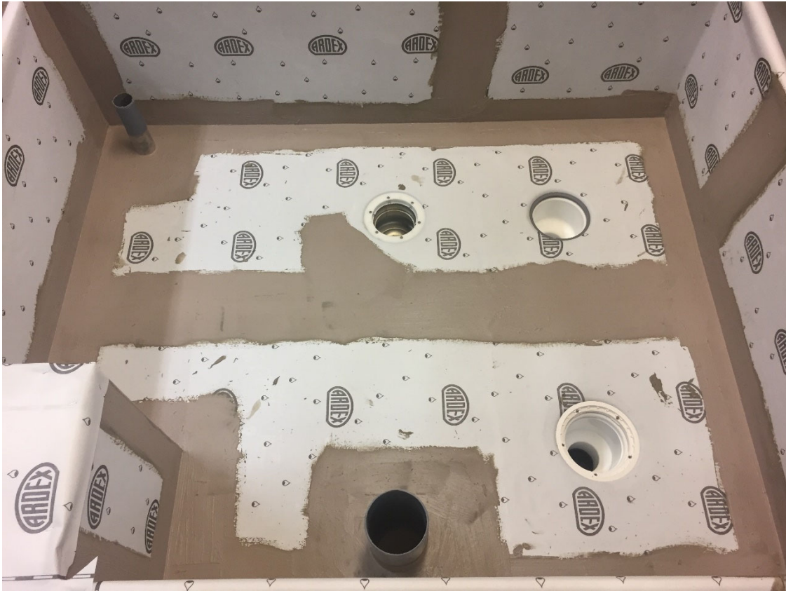
Provlådan färdig för provning
