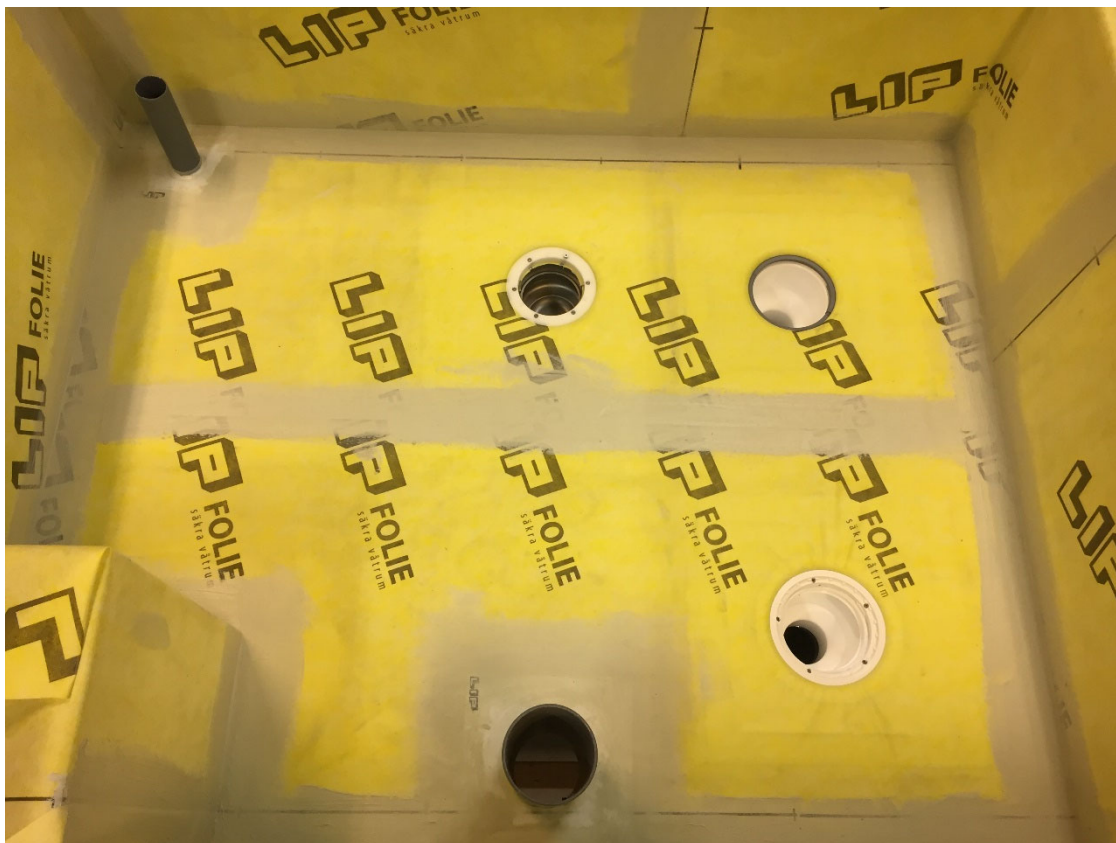
Provlådan färdig för provning
