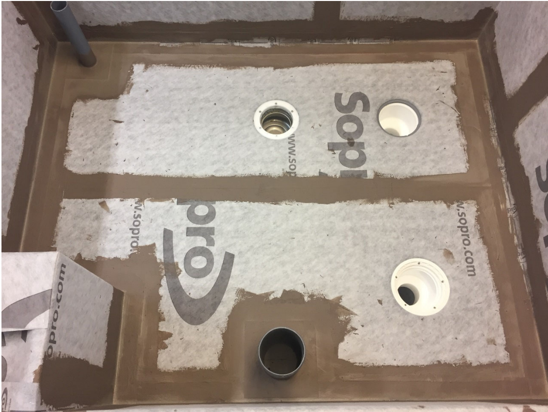
Provlådan färdig för provning
