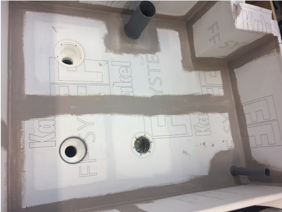
Provlådan färdig för provning
