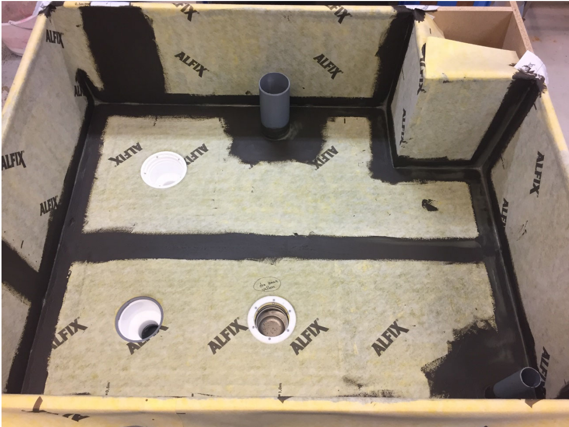
Provlådan färdig för provning
