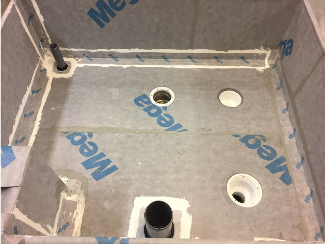
Provlådan färdig för provning
