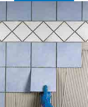
Montering af enkeltbrændte fliser på gipspladevægge
