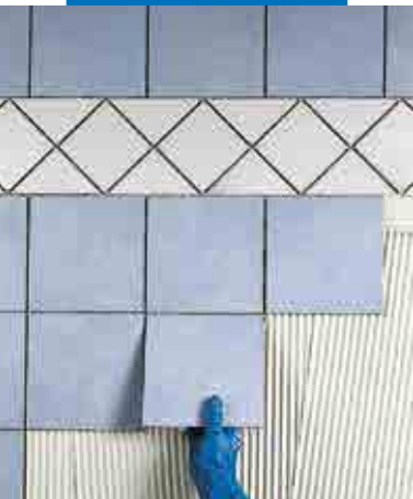
Installation av plattor på gipsskivevägg
