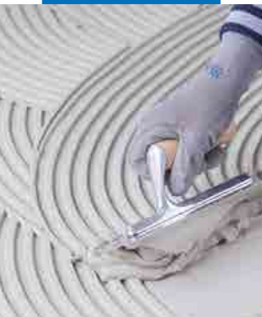
Installation av enkelbrända plattor på putsad vägg
