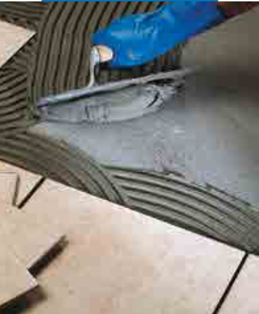
Enkelbrända plattor på golv
