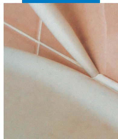
Fogning mellan handfat och vägg med Mapesil AC
