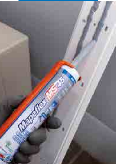
Limning af plastikprofiler på udendørs overflade
