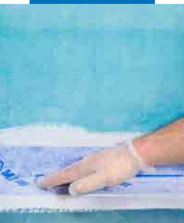
Indbygning af Mapei ST tettebånd ved hjælp af Mapegum WPS, overgang gulv/væg
