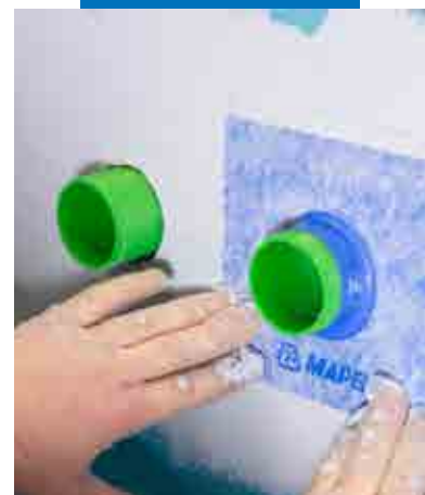
Indbygning af Mapei Rørmanschett forsegling ved rørgennemføring med Mapegum WPS
