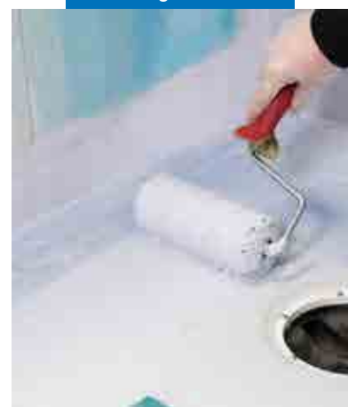
Påføring af Mapegum WPS med rulle
