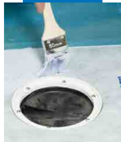
Butyl manchet (selvklæbende) ligges ned over afløb( på færdig primet gulv). Derefter påføres Mapegum WPS over manchet og over resten af gulvet
