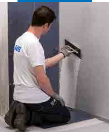
Påføring af flislim
