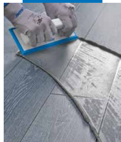
Fordeling af Ultracolor Plus på gulv med gummispartel
