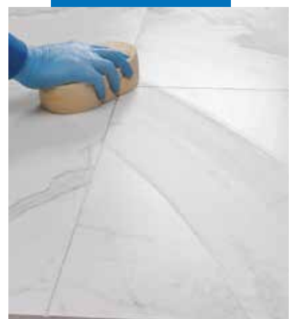
Rengøring og færdigbehandling af fugerne med hård cellulose svamp
