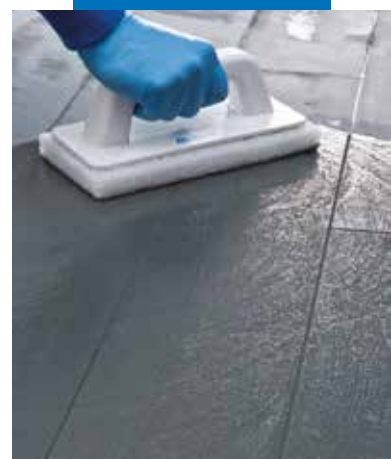
Rengøring og efterbehandling af flisefugerne med en svamp
