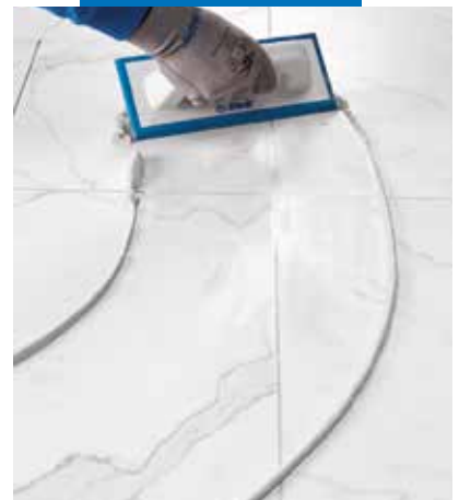
Udlægning af Ultracolor Plus med gummispartel, på gulvfliser med marmor-effekt
