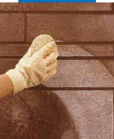
Rengøring og efterbehandling af flisefugerne på en væg med en svamp
