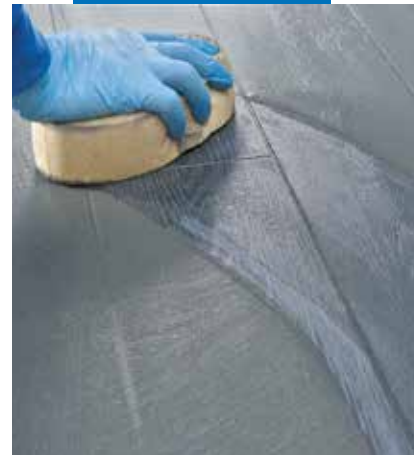
Rengøring og efterbehandling af flisefugerne med en svamp
