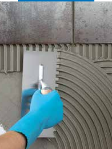
Fordeling af Ultralite S1 med en tandspartel på væg
