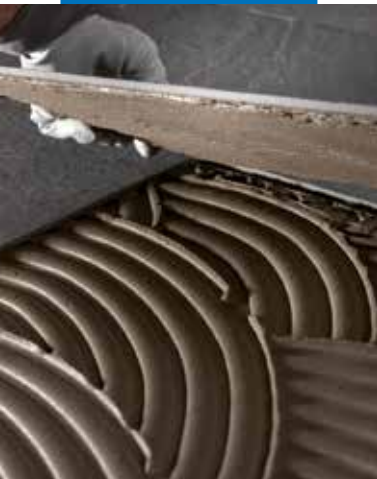
Montering af tynde porcelænsfliser på gulv
