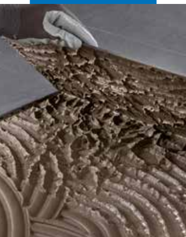
Kontrol af fuld dækning på bagsiden af tynde porcelænsfliser
