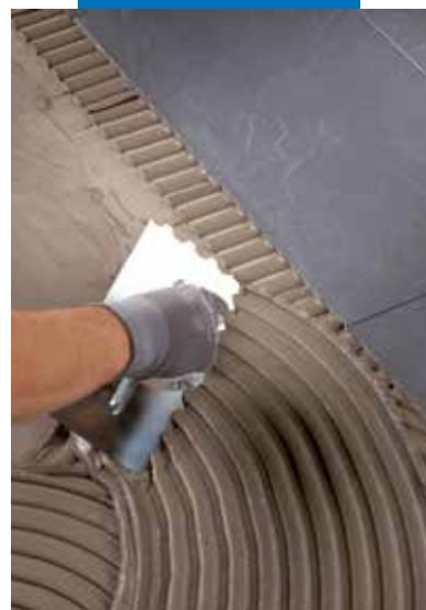
Fordeling af klæbemiddel på gulv med en 9 mm rund tandspartel
