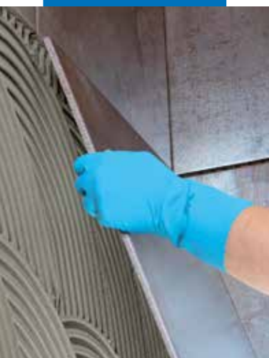
Montering af store fliser på vægge
