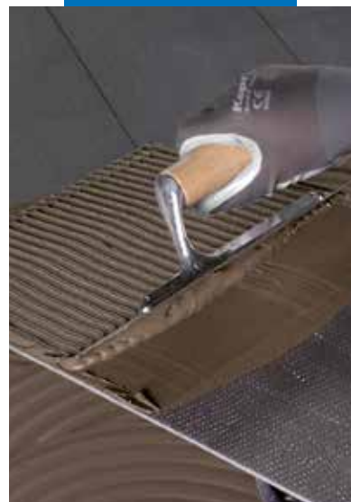
Fordeling af klæbemiddel på bagsiden af fliserne
