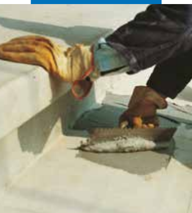
Påføring af Adesilex PG1 med tandspartel til strukturel limning af støbte trin
